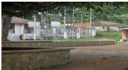
Foto 7 Hidroeléctrica de Asnazú
