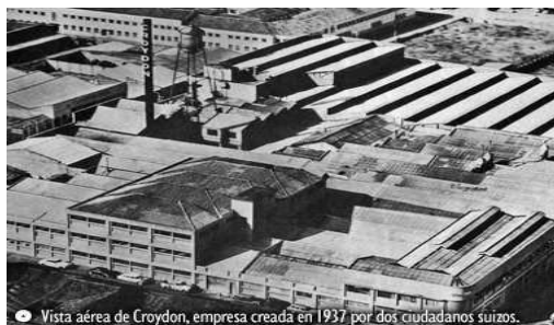
Foto 6 Empresa Croydon 1937 Cali.
